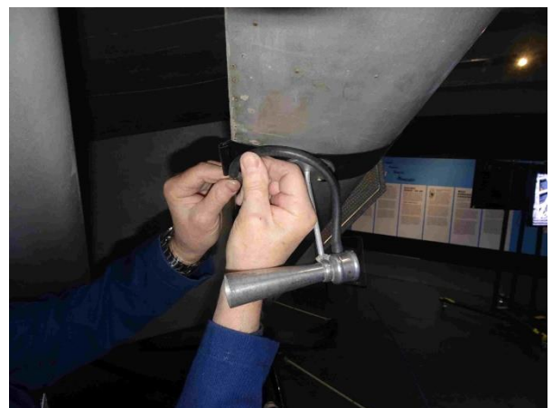
Kumista liitosputkea asennetaan paikoilleen
