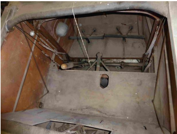
Ohjaamo ennen kunnostamista
