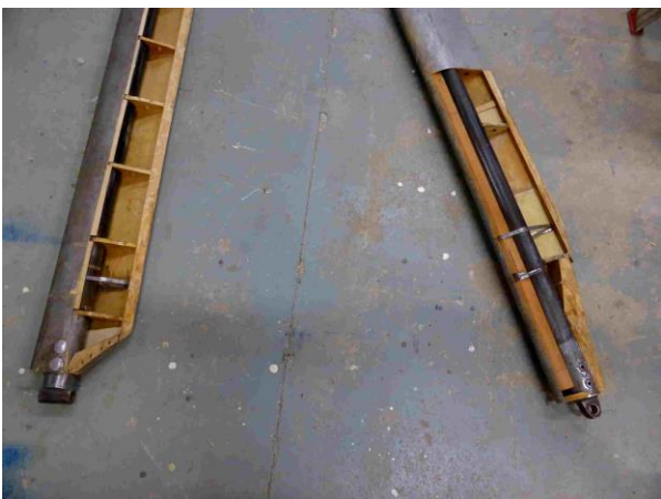
Alkuperäisten siipitukien rakenne näkyvissä
