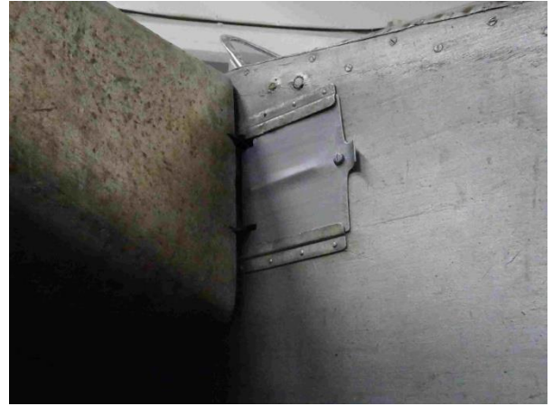
Uusi luukku paikoillaan liukukiskoissa
